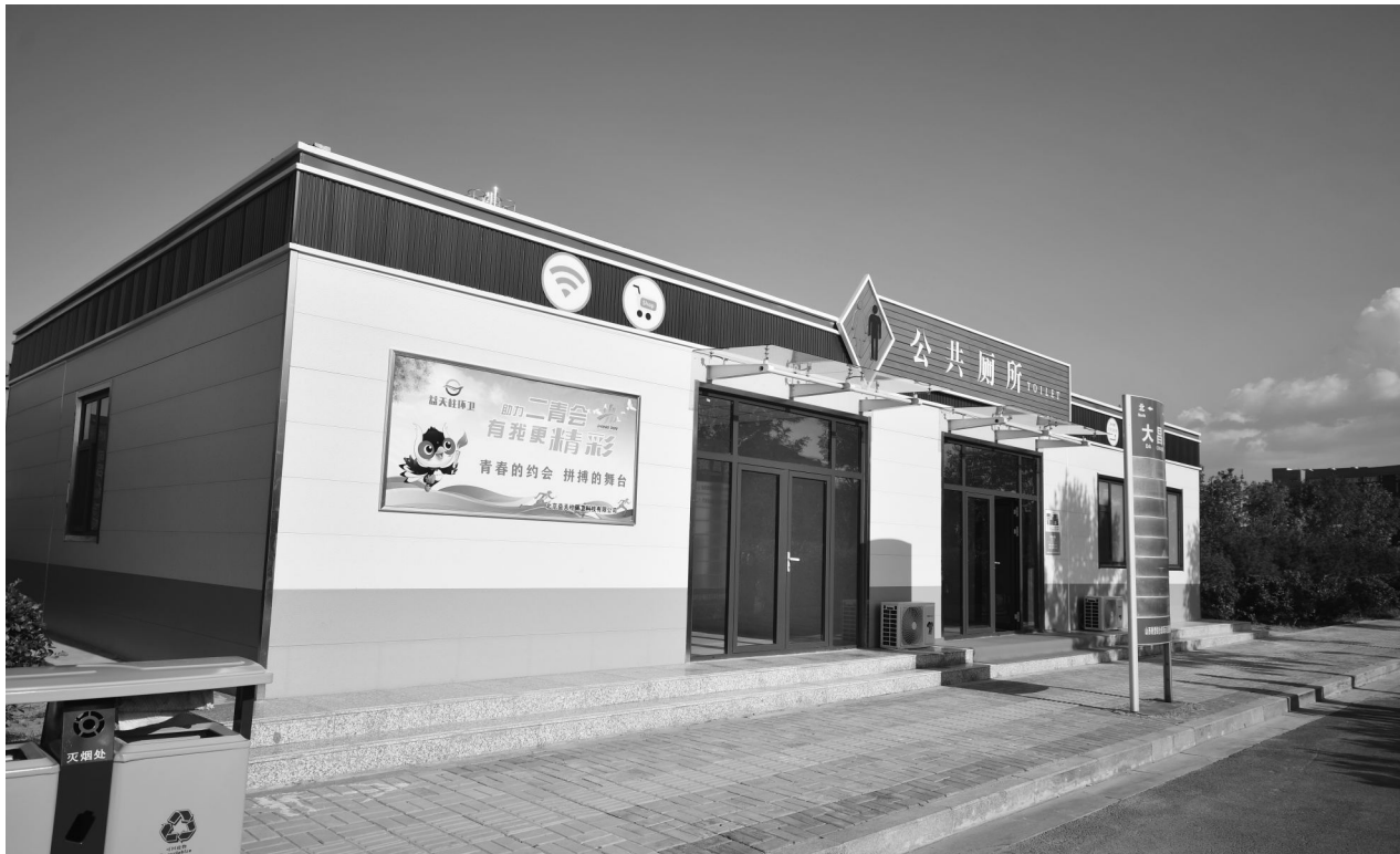
综改区新建成的一座公厕。 本报记者 姚 凡 摄
