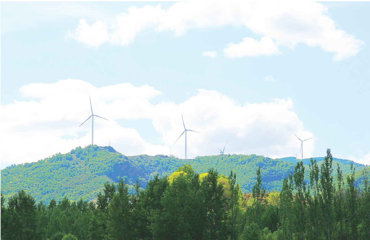
日前，国电方山马坊(一期)48MW风电项目正式并网发电。国电方山马坊48MW风电项目总投资4.5亿元，包括24台2.0MW风力发电机组及配套设施。该项目的投产，将进一步优化全市电力结构，壮大新能源产业规模，为节能减排作出积极贡献。
