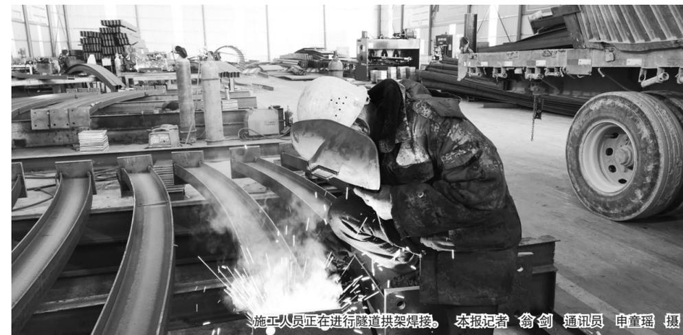
施工人员正在进行隧道拱架焊接。本报记者 翁剑 通讯员 申童瑶 摄
