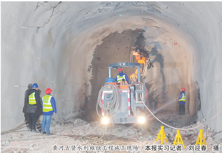
黄河古贤水利枢纽工程施工现场。本报实习记者 刘迎春 摄
